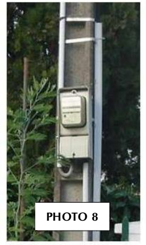
Compteur extérieur apparent
