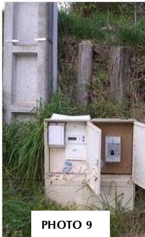
Compteur et disjoncteur dans coffrets extérieurs (généralement dos à dos)
